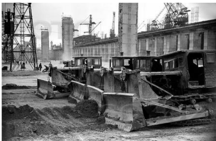
Сталинградская (ныне - Волжская) гидроэлектростанция, утранбовка дна водосливной плотины. 1953-1955
